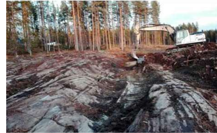
Innan borrning avlägsnas allt löst material från berget (avtäckning)
